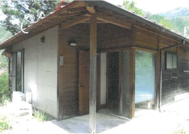
出羽コテージ現況写真 B棟
