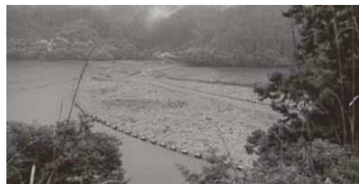
令和8年台風第6号での流木捕捉状況
