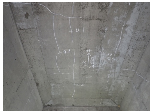
コンクリート床版のひびわれ
