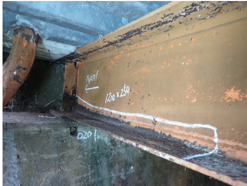
鋼桁の腐食
