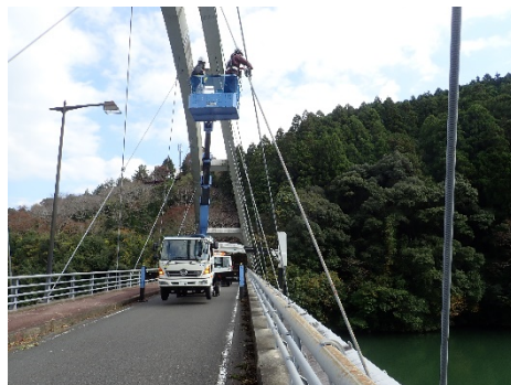
写真 2 高所作業車による点検
