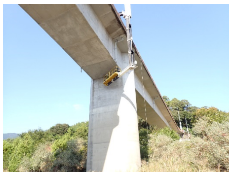
写真 1 橋梁点検車による点検
