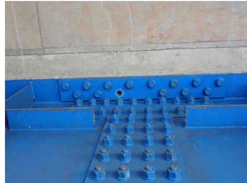
添接ボルトの脱落
