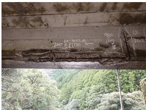
コンクリート桁の鉄筋露出
