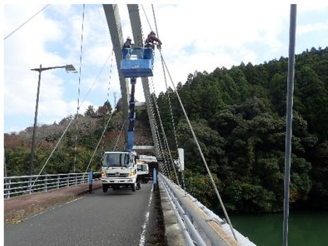
写真2 高所作業車による点検
