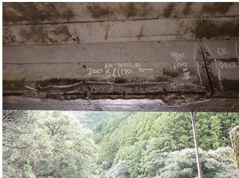
コンクリート桁の鉄筋露出
