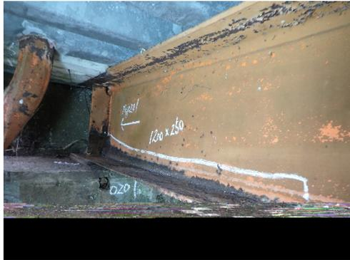
鋼桁の腐食
