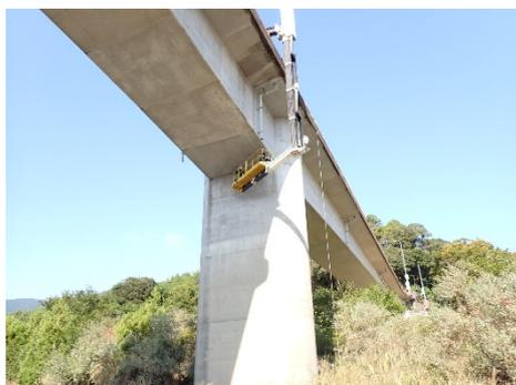
写真1 橋梁点検車による点検
