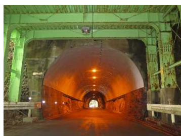
⑩大戸第三トンネル
