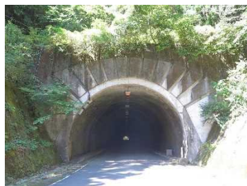
⑦星越トンネル
