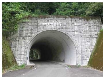
④追立1号トンネル
