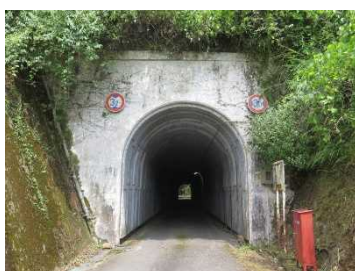
②桜谷トンネル
