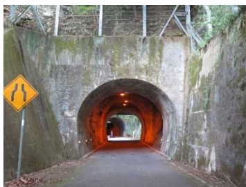
⑧大戸第一トンネル
