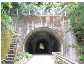
⑤追立2号トンネル
