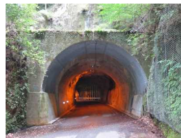
⑨大戸第二トンネル
