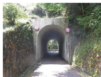
③正木谷トンネル
