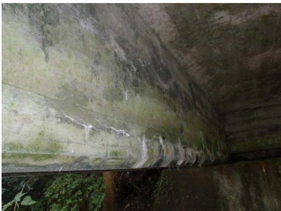
コンクリート桁のひびわれ・遊離石灰
