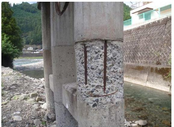
コンクリート橋脚の剥離・鉄筋露出
