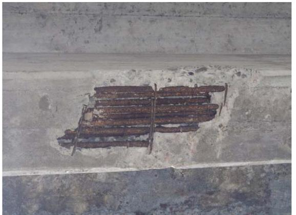
コンクリート桁の剥離・鉄筋露出
