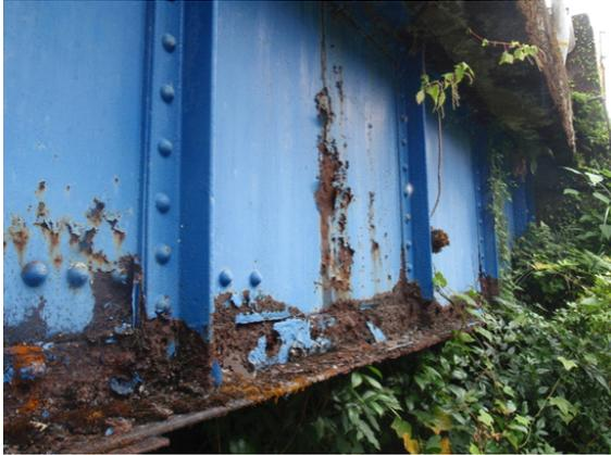
鋼桁の腐食
