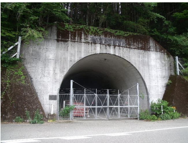
荒谷トンネル 入口付近
