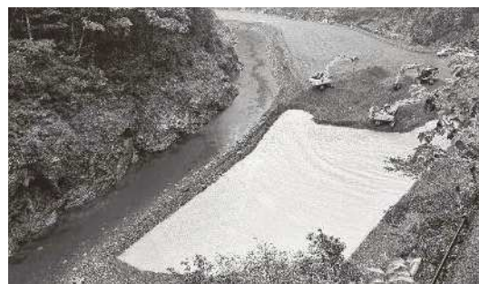
写真① 堆砂除去工事の状況（追立地区）
