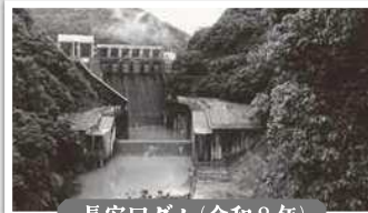
長安口ダム(令和8年)
