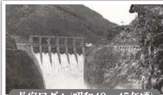
長安口ダム(昭和40～45年頃)
