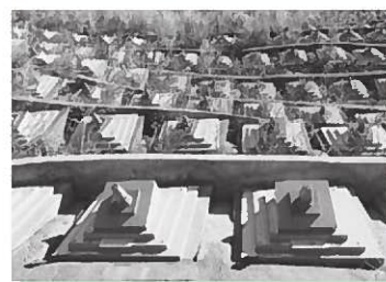
写真：阿津江地区のアンカー工
