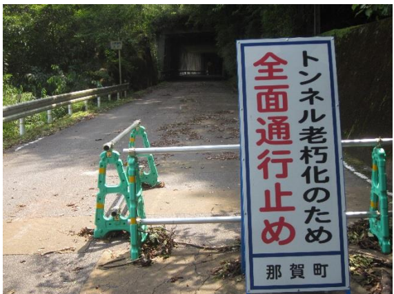
トンネル通行止め箇所
