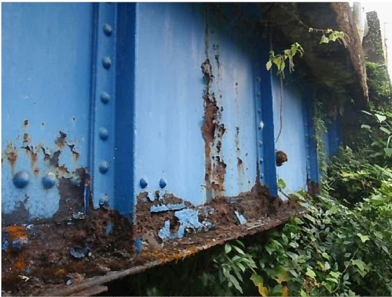
鋼桁の腐食
